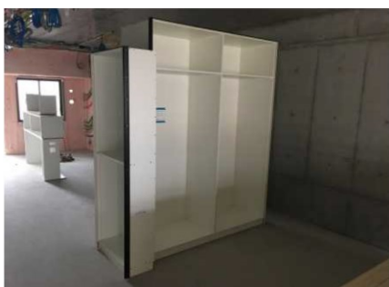
押入れ・物入れのユニット
