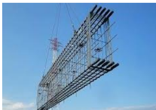
梁鉄筋地組取付
