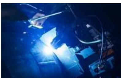
高速溶接技術
