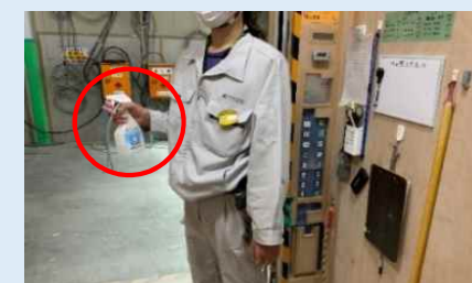
EVの操作盤等の消毒を徹底
